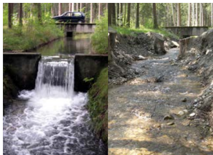
Umbau einer Sohlschwelle in eine Raue Rampe
